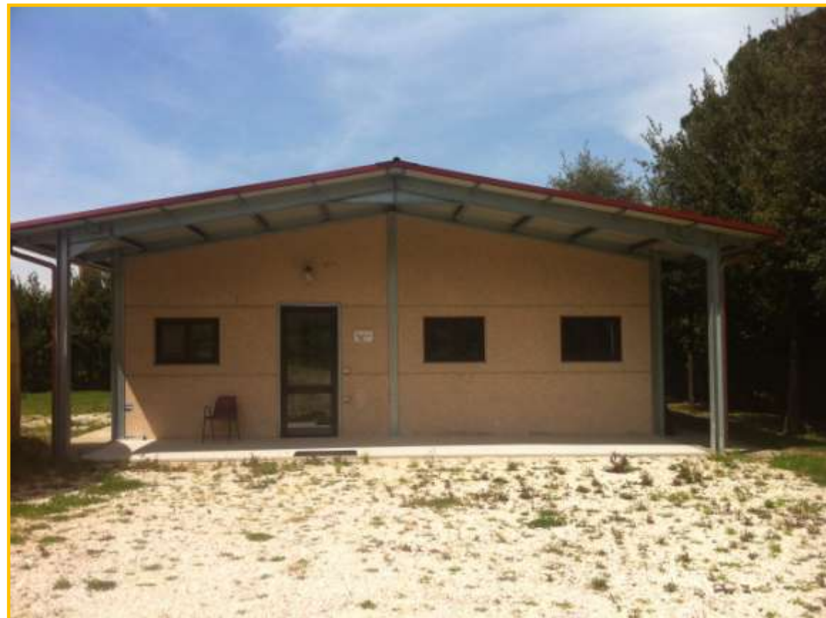
La facciata del Centro Rosa Thea, dove vengono realizzate molte attività dei progetti di SoliS
